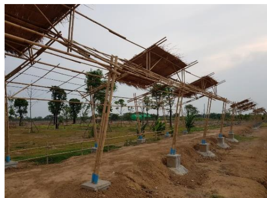
การทำซุ้มไม้ไผ่และที่กันดินบริเวณซุ้มไม้ไผ่
