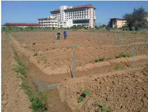
การยกคันดิน ขุดคลองสร้างระบบระบายน้ำภายในแปลง
