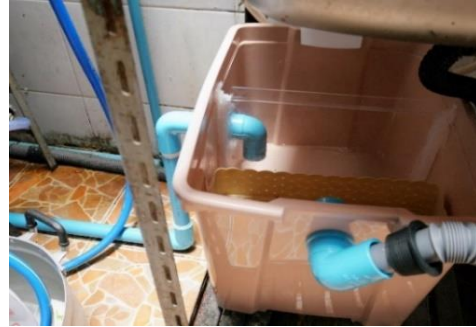
ภาพที่ 2 แสดงลักษณะภาพถังดักไขมันที่ใช้จริงในร้านอาหาร
