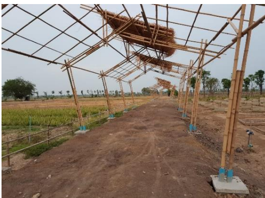
การทำซุ้มไม้ไผ่และที่กันดินบริเวณซุ้มไม้ไผ่
